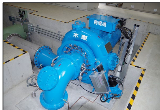
河内川ダム小水力発電所 (渦巻フランシス水車)
