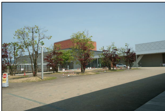
スクルーヒートポンプ 3基 1100m 3 蓄熱槽
