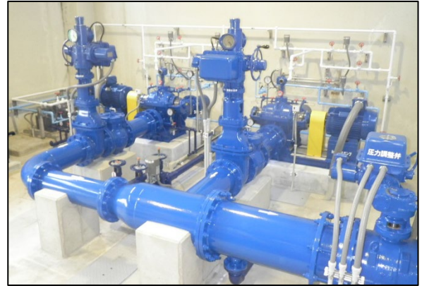
六条和田第5号揚水機場
