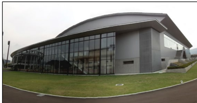
空調・衛生器具・給排水等設備
