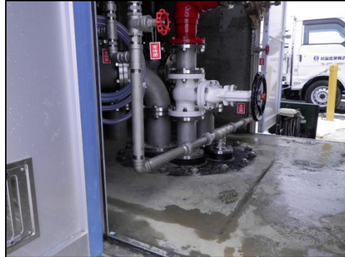
非常用給水装置
