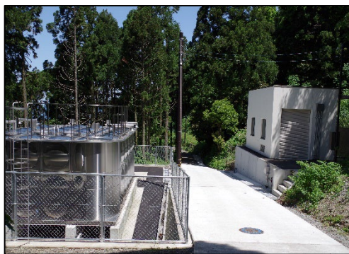
浄水場施設外観
