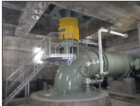
No. 3 雨水ポンプ先行待機型立軸斜流ポンプ (II型) φ1800×562m 3 /min×10.4m
