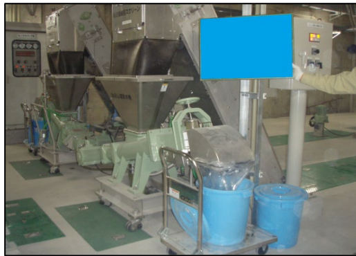
沈砂設備（微細目スクリーン裏かき式微細目 スクリーン除塵・し渣脱水機二軸対向スクリュウ式）
