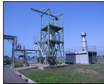
余剰ガス燃焼装置
