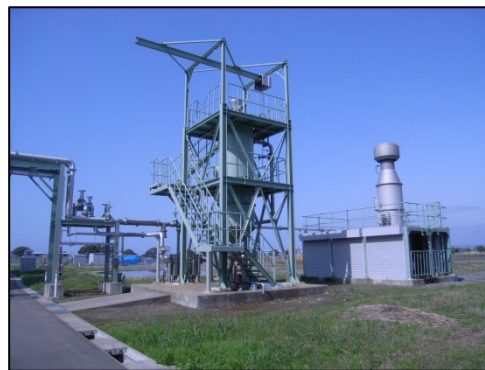
沈砂設備（微細目スクリーン裏かき式微細目 スクリーン除塵・し渣脱水機二軸対向スクリュウ式）
