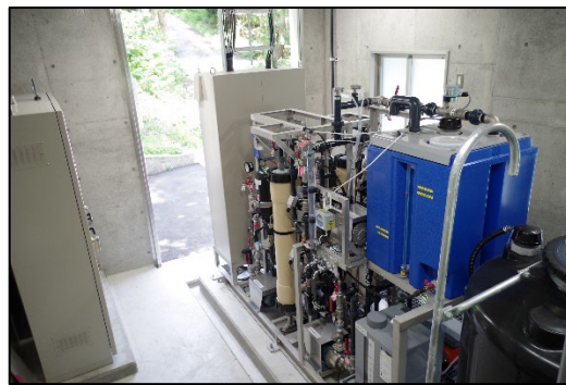
膜ろ過装置 (MF 膜)
