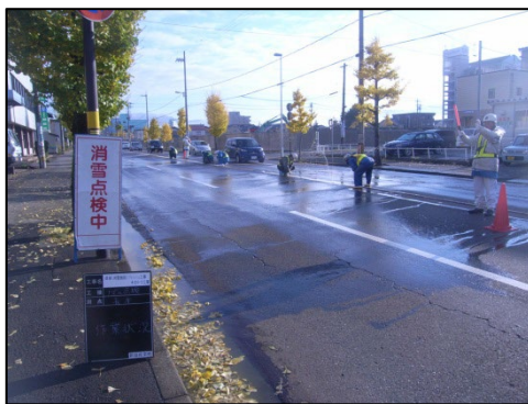
消雪点検工事作業状況
