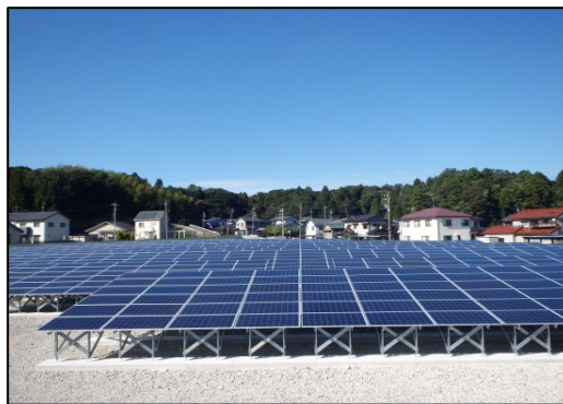
太陽光発電所
