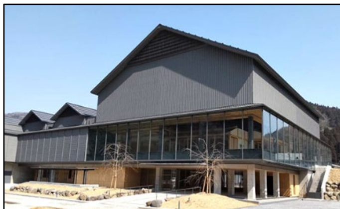
空調・衛生器具・給排水等設備
