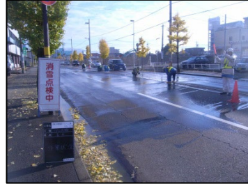
消雪点検工事
