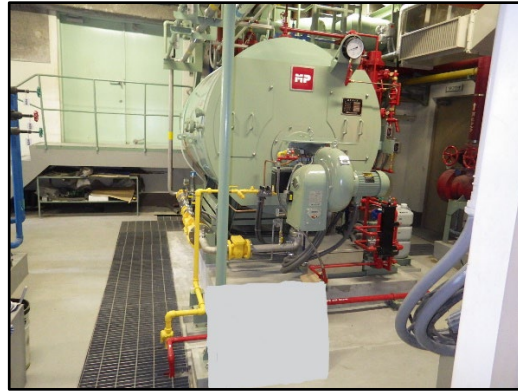
加温ボイラー
