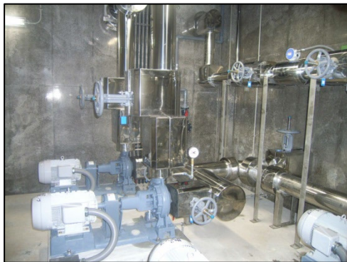
口径φ100×φ80 (2.2m 3 /min×15m×11kw×200v×2 台) 口径φ80 (0.57m 3 /min×66m×15kw×200v×3 台)
