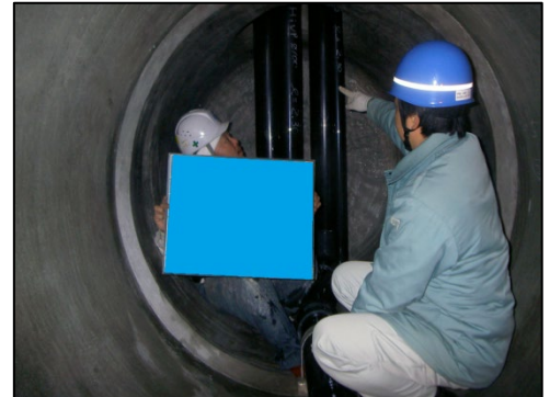
DCPLUFφ1500 貯水槽内部
