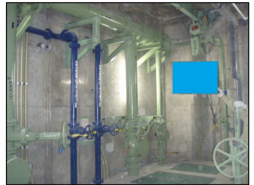
主ポンプ設備（污水ポンプ吸込スクリュウ付 污水ポンプ・ポンプ井連絡ゲート手動式鑄鉄製角形）
