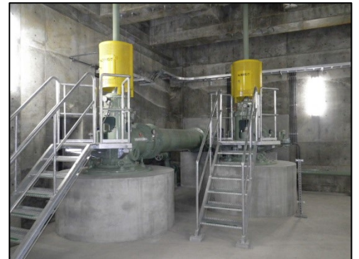
No. 1,2 雨水ポンプ立軸斜流ポンプ (II型) φ600×55m 3 /min×10.5m
