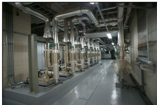
冷温水ポンプ 8台 ヘッダー 4基
