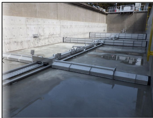
モノレール式汚泥掻寄機
