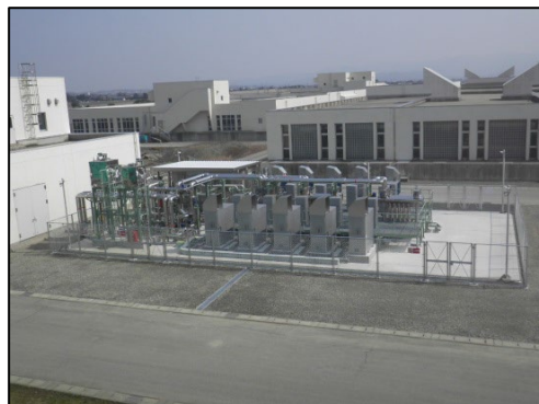
バイオマス（消化ガス）発電装置
