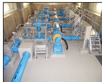
武生第一中継ポンプ場
