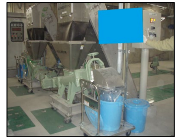
沈砂設備（微細目スクリーン裏書き史記微細目スクリーン除塵・し渣脱水機二軸対向スクリュース式）
