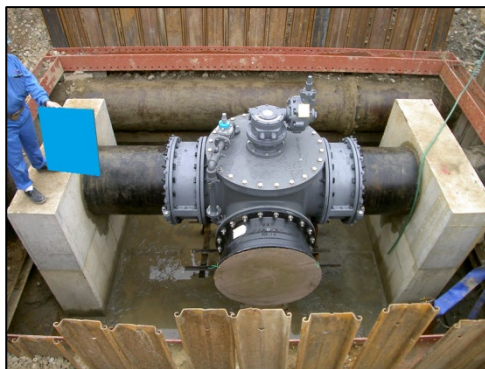
インサートバルブT型 C I P φ800×φ800
