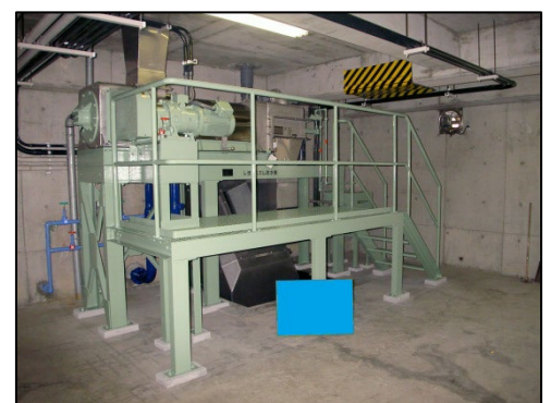
し渣・スカム脱水機 スクリュー式
